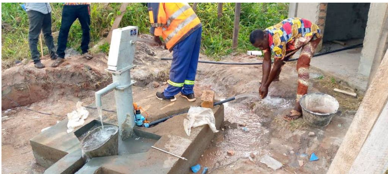
Hier wurde die mechanischen Pumpe getestet. Das Wasser sprudelte bereits unmittelbar nach dem Einbau.
